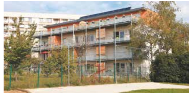
Logements collectifs BBC à Besançon (25).
